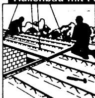
Elementdecken mit Gitterträgern
